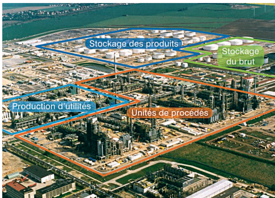
La raffinerie de Leuna, en Allemagne, construite par Technip et démarrée en 1997.
