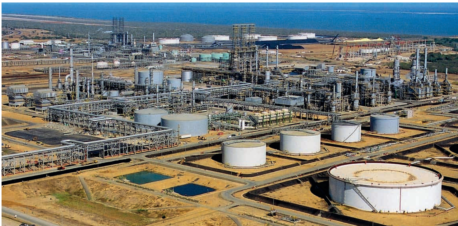
La raffinerie de Sincor au Venezuela, construite par Technip et démarrée en 2001.
