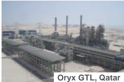
Oryx GTL, Qatar
